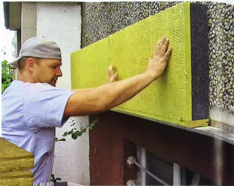
Skladba zateplovacieho systému: 1 – obvodové murivo 2 – Austrotherm GrEPS 80 F Reflex 3 – lepiaca malta 4 – výstužná vrstva – lepiaca malta s integrovanou textilnou mriežkou zo sklenených vlákien 5 – penetračný náter 6 – finálna fasádna povrchová vrstva
